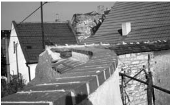
Koruna zdiva bašty byla zakryta novými ostře pálenými cihlami
