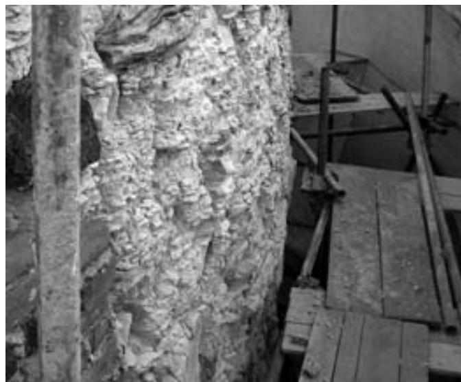
Poměrně složitá byla už stavba lešení na úzkém prostoru mezi baštou a sousedním domem.
