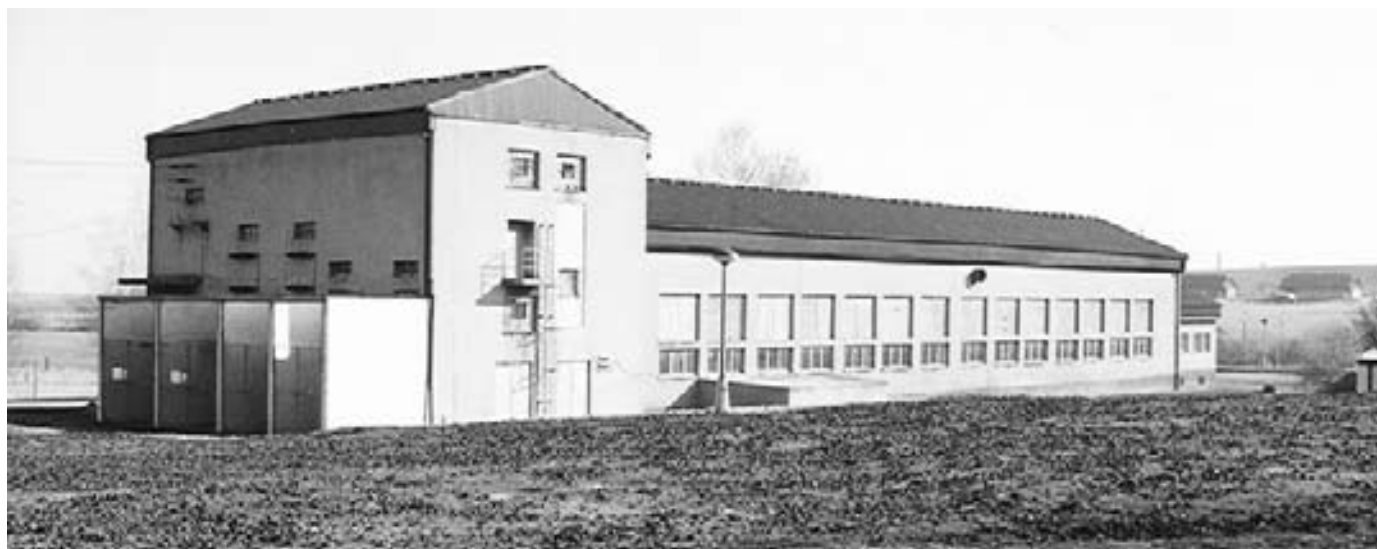
Třetí buštěhradský vodojem – čerpací stanice po rekonstrukci, foto: Jaroslav Pergl
