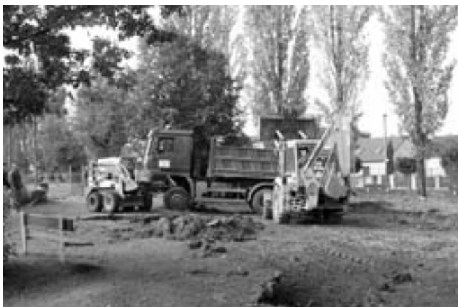
Výkopy pro základy herních prvků. Foto tým Hřiště
