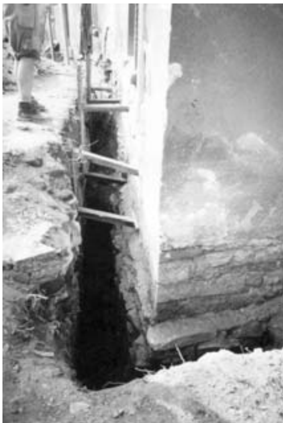
Odkopání domu zvenku (foto autorka)
