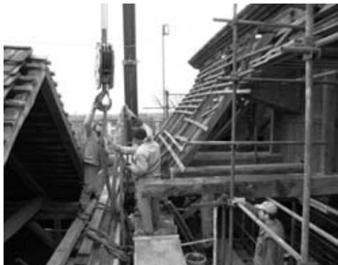
Detail - vpravo část mansardové střechy nad sálem s rozebranou krytinou.
