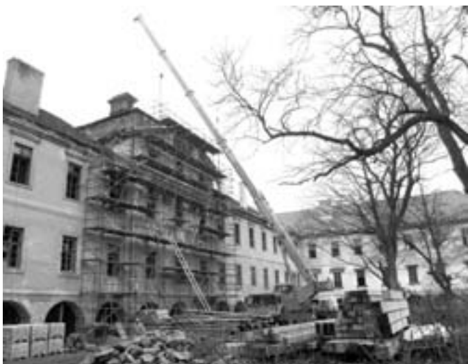
Do zámeckého krovu se pomocí jeřábu dopravuje nový trám.
