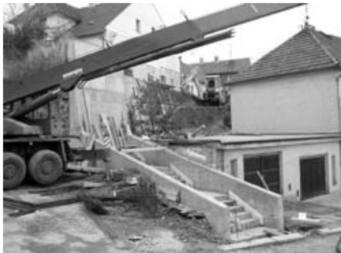
Oprava schodiště u DPS. Foto: JK
