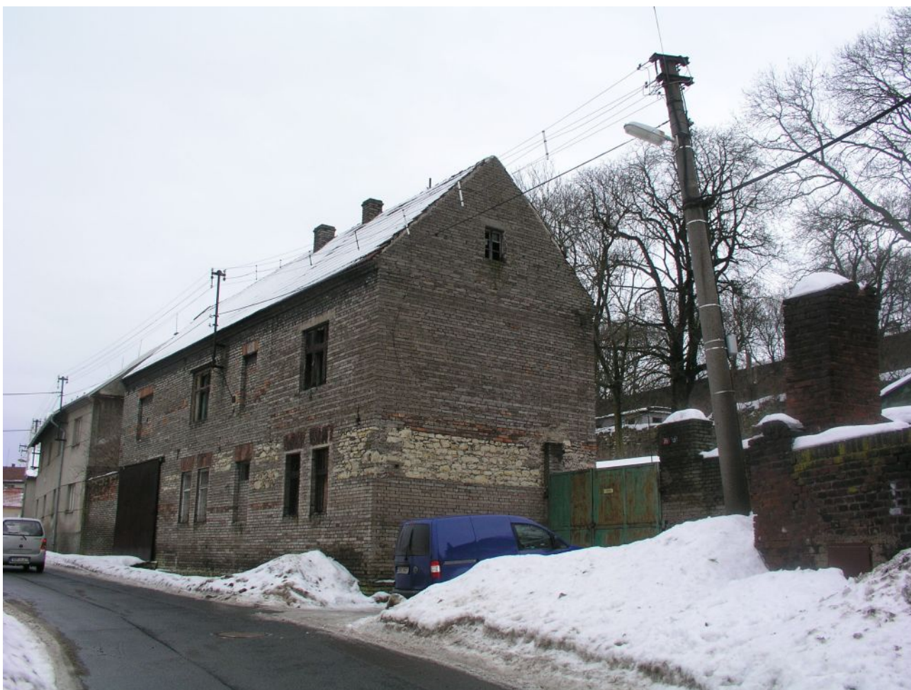
LOKALITA Z3-1 Fotografie objektu čp. 71 od východu a západu z ulice Pražské
